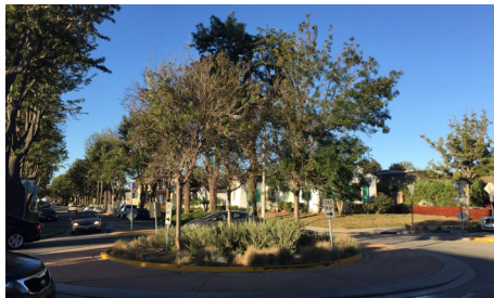
图7 增加小型交通岛实施照片 资料来源:作者自摄。
